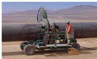
:: SOLDADURA POR TERMOFUSIÓN ::
