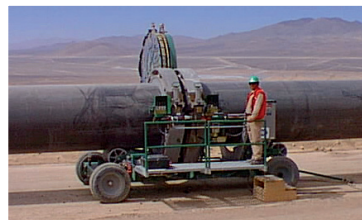
:: SOLDADURA POR TERMOFUSIÓN ::
